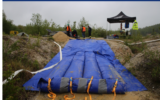
Abb. 3 Ausbringung von TeD mit einer Füllung aus Wasser-Sand
