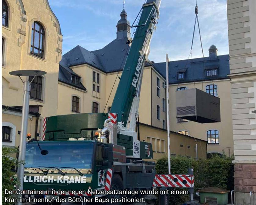
Der Container mit der neuen Netzersatzanlage wurde mit einem Kran im Innenhof des Böttcher-Baus positioniert.
